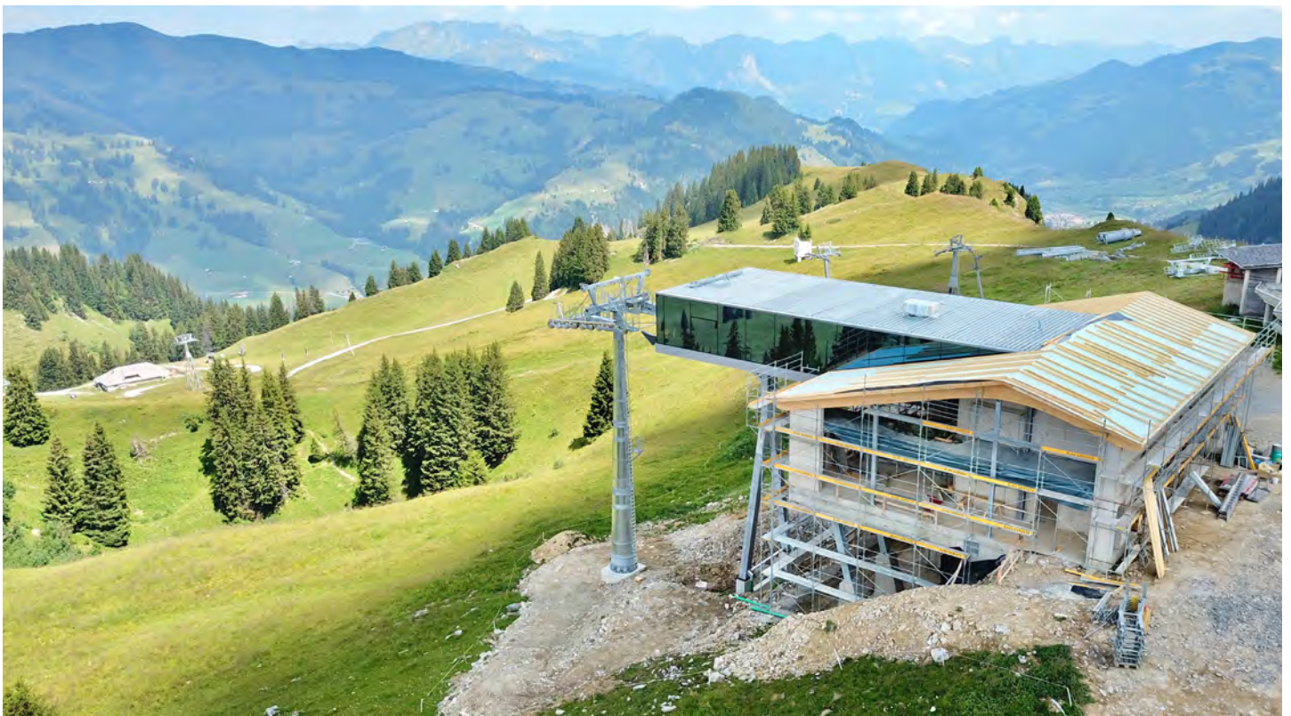
Foto der Baustelle Saanersloch
