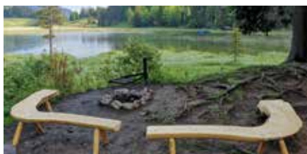
Erstellung und Renovierung zahlreicher Genuss- und Grillplätze.
