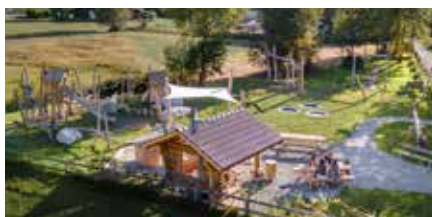
Bau von neuem Spielplatz in Schönried.
